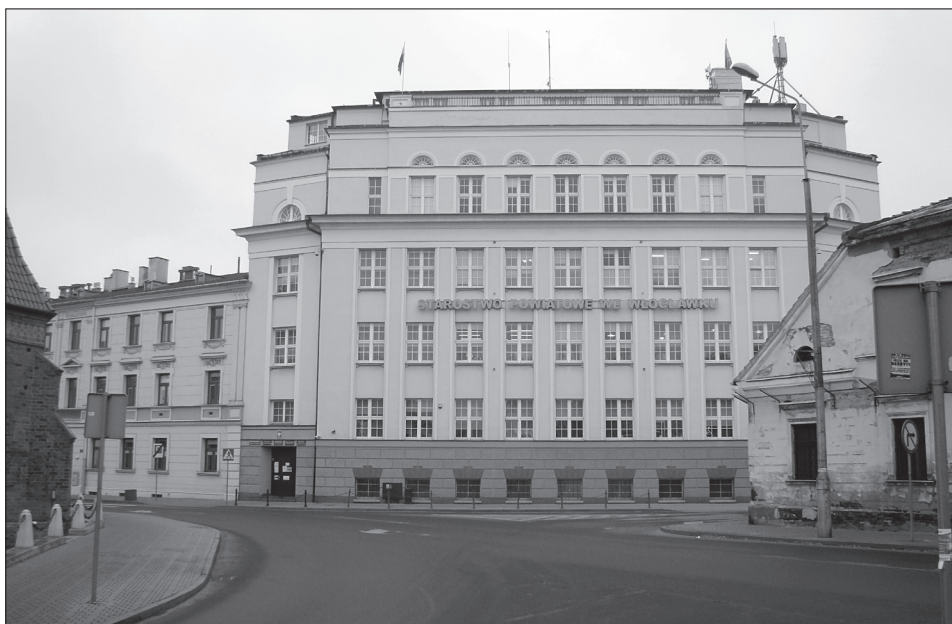
Kompleks budynków Szkół Żeńskich zbudowany przez J. Steinbok (ul. Cyganka 28/30 i Przejazd 5)
