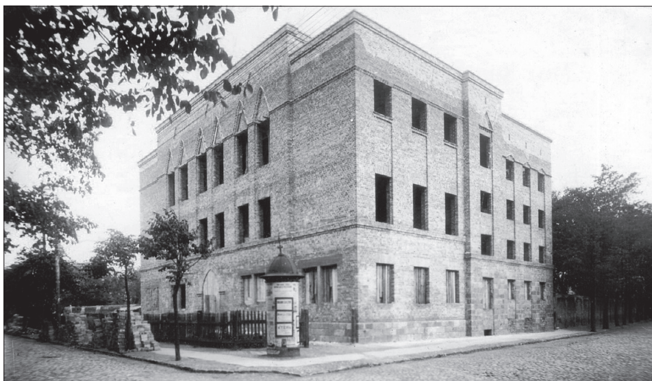
Budynek siedziby OK PTK w budowie, 1928 r., wyk. Zakład fotograficzny „K. Szałwiński”, Włocławek 1933 r.
