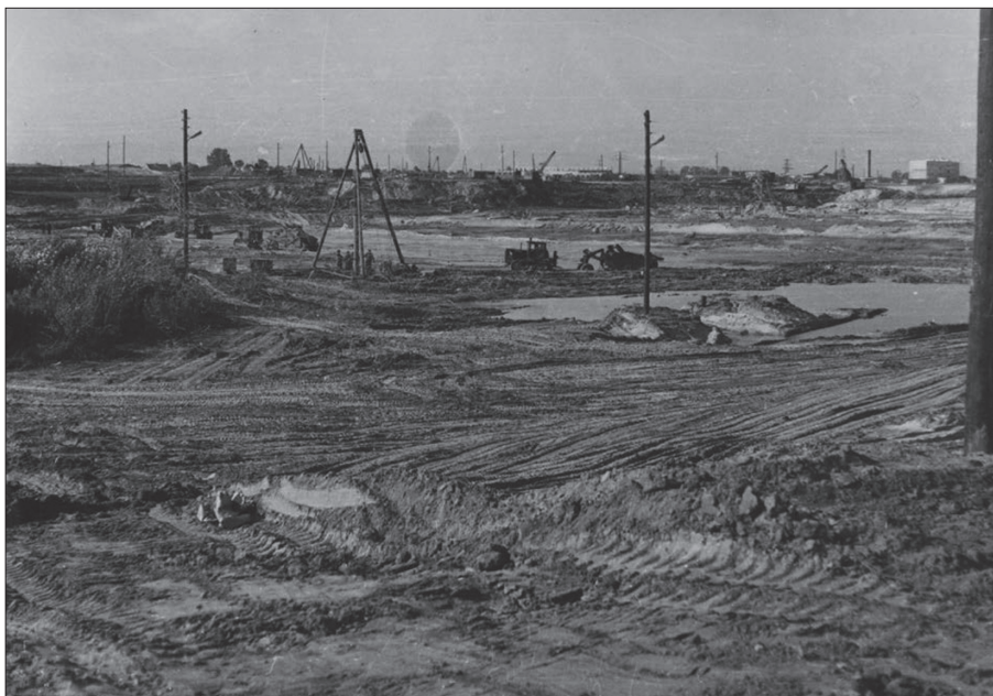
Budowa stopnia wodnego, 1964 r. (źródło: APTOW, Zarząd Inwestycji, sygn. 180, k. 10)
