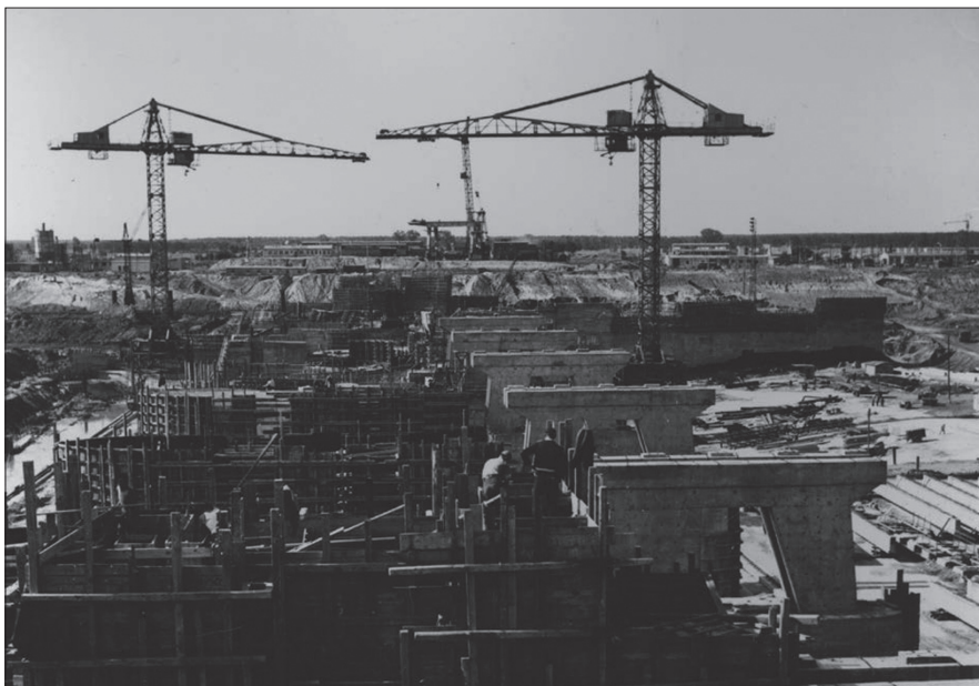
Budowa stopnia wodnego, 1967 r. (źródło: APTOW, Zarząd Inwestycji, sygn. 180, k. 34)
