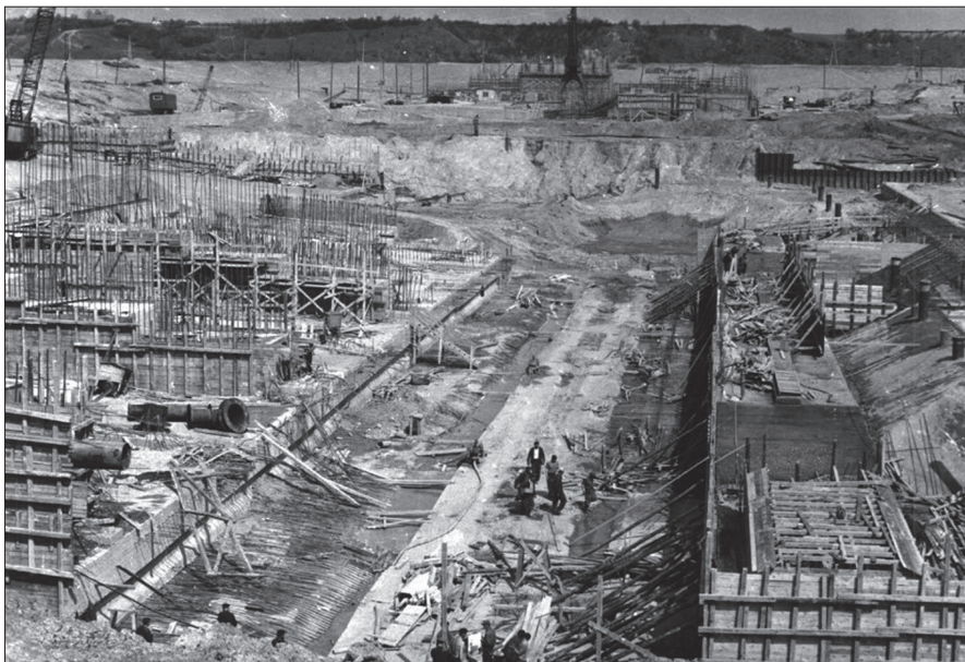
Budowa stopnia wodnego, 1966 r. (źródło: APTOW, Zarząd Inwestycji, sygn. 180, k. 23)
