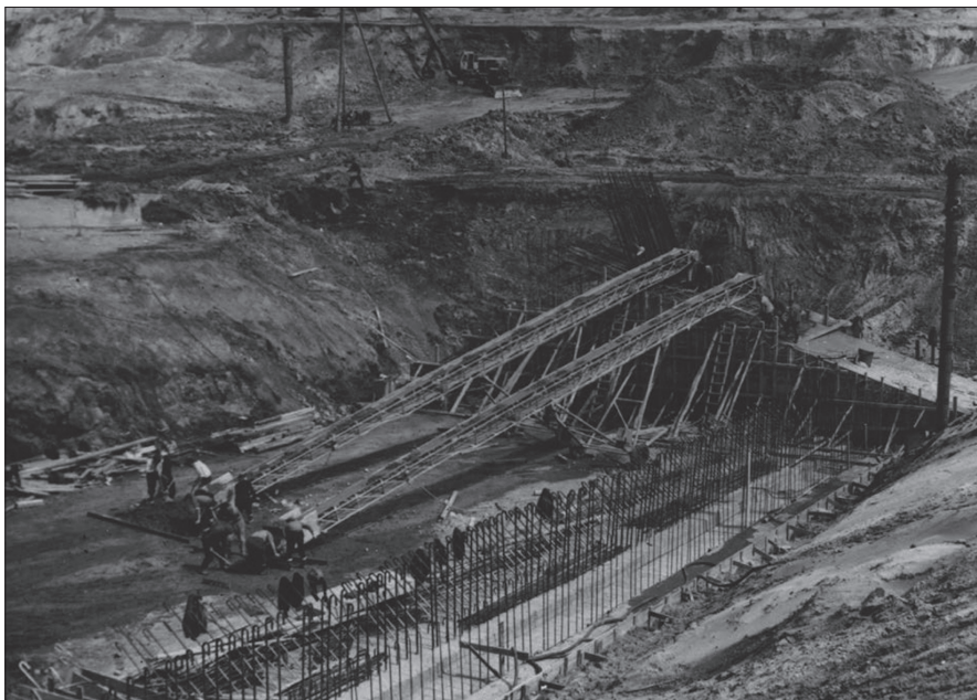
Budowa stopnia wodnego, 1965 r. (źródło: APTOW, Zarząd Inwestycji, sygn. 180, k. 12)
