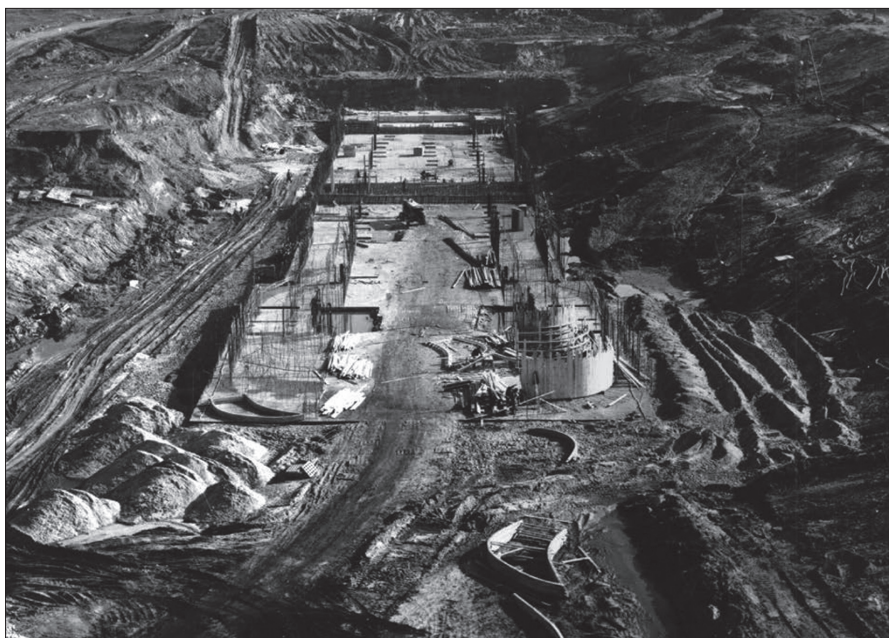
Budowa stopnia wodnego, 1966 r. (źródło: APTOW, Zarząd Inwestycji, sygn. 180, k. 26)
