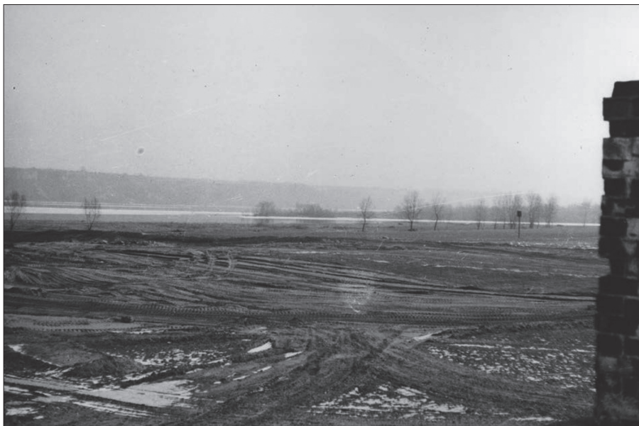
Budowa stopnia wodnego, 1962 r. (źródło: APTOW, Zarząd Inwestycji, sygn. 180, k. 3)
