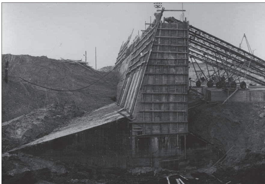
Budowa stopnia wodnego, 1965 r. (źródło: APTOW, Zarząd Inwestycji, sygn. 180, k. 14)
