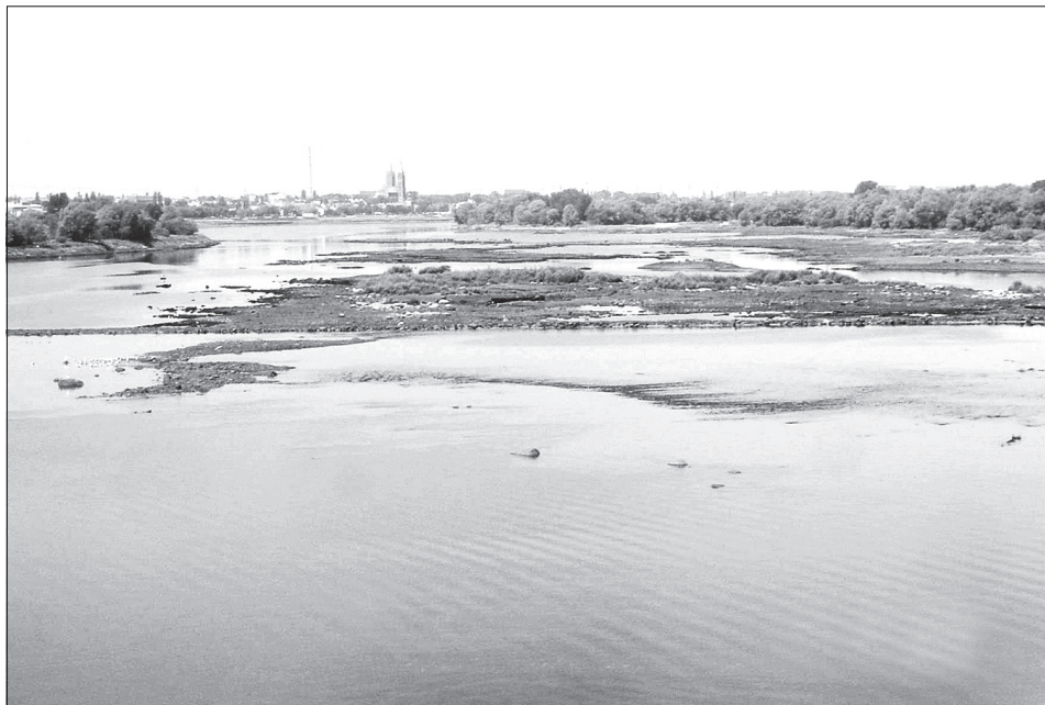
Fot. 1. Erozyjne dno koryta Wisły poniżej zapory czołowej we Włocławku, zbudowane z ilu pokrytego głazami, pochodzącymi z wymycia gliny morenowej, fot. z zapory 8 VI 2007 r.
